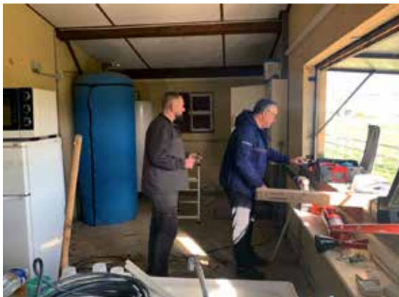
Mise à jour des installation électriques.
