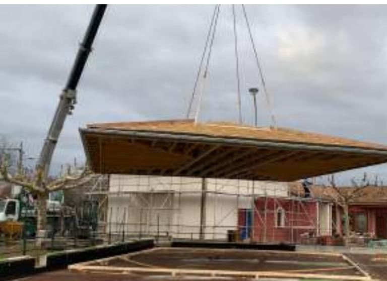
Pose de la toiture de l'agrandissement avec une grue.
